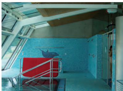
Obr. 14 Presadacie stupne a stropné koľajnicové zdvíhacie zariadenie do bazéna (škola, Schwechat, Rakúsko)
