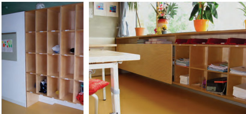
Obr. 9, 10 Úložné priestory so soklom na zasunutie stúpačiek vozíka (škola Schwechat, Rakúsko)
